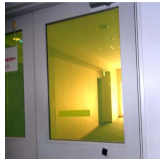
防虫フィルム施工例
