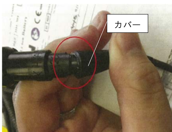
図 5-22：体外ケーブルのカバーの外れ
